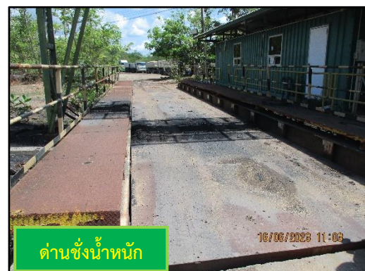
ภาพที่ 2.23 ด้านขังน้ำหนักถบรรทุกพร้อมห้องควบคุม
